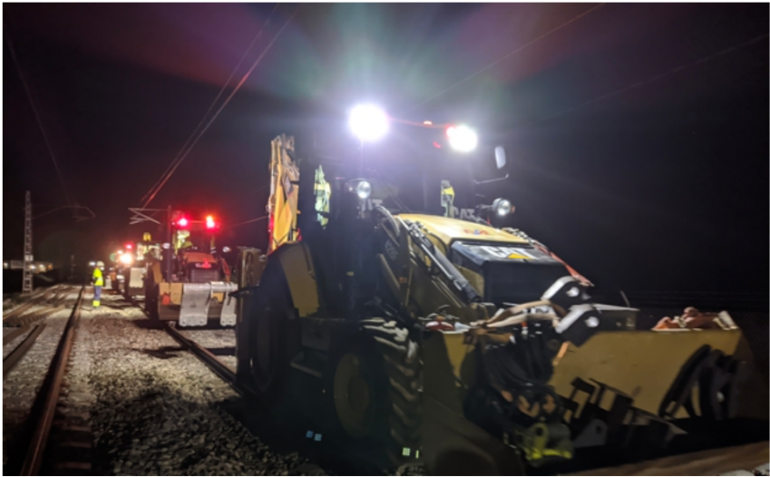
Obras de mejora de las vías en el área de Benifaió. / A. T.
